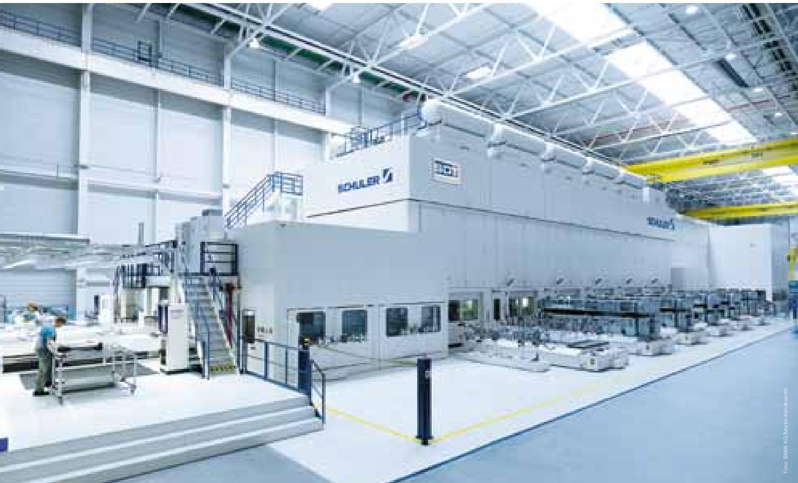
Pressenlinie von Schuler, wie sie unter anderem bei BMW in Leipzig, Deutschland, in Betrieb ist.
