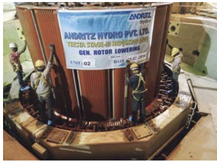
Mise en place de l'alternateur
