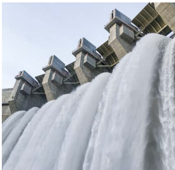
La centrale de pompage turbinage de Goldisthal, Allemagne
