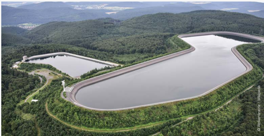
En 2017, Uniper Kraftwerke GmbH / Allemagne a installé les systèmes dans la CPT de Waldeck 1 (une pompe à turbine de 70 MW) et Waldeck 2 (deux unités ternaires de 240 MW chacune).
