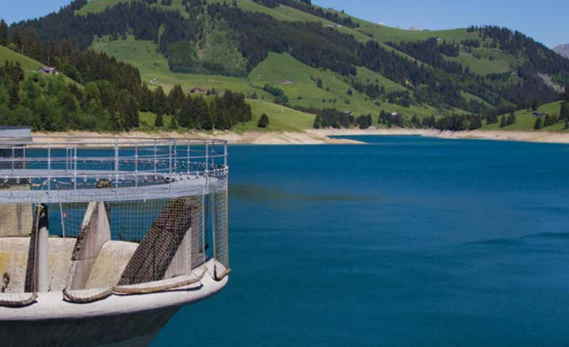
Vue du réservoir, lac de l'Hongrin
