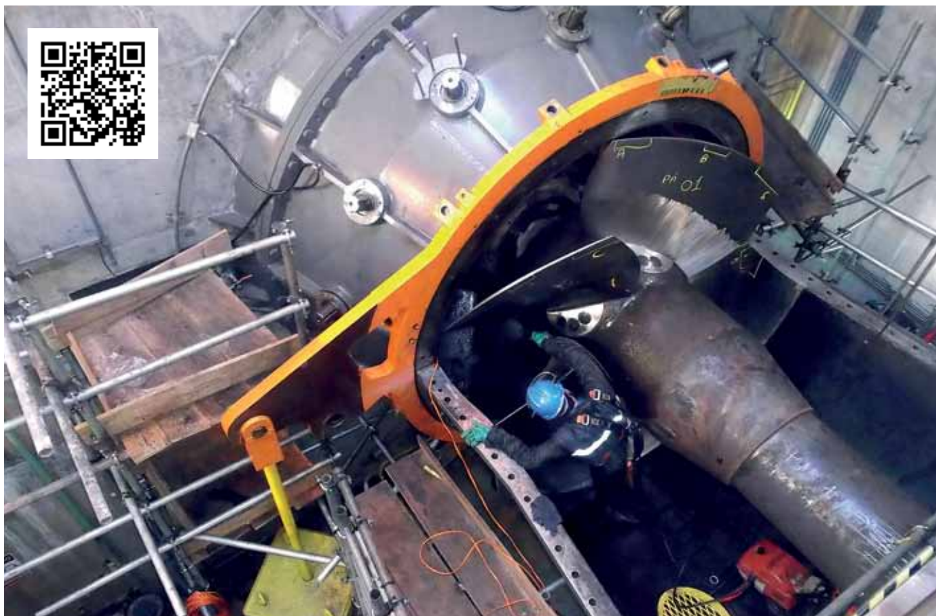
▼ Manutenção do rotor Kaplan no projeto Mogi Guaçu
