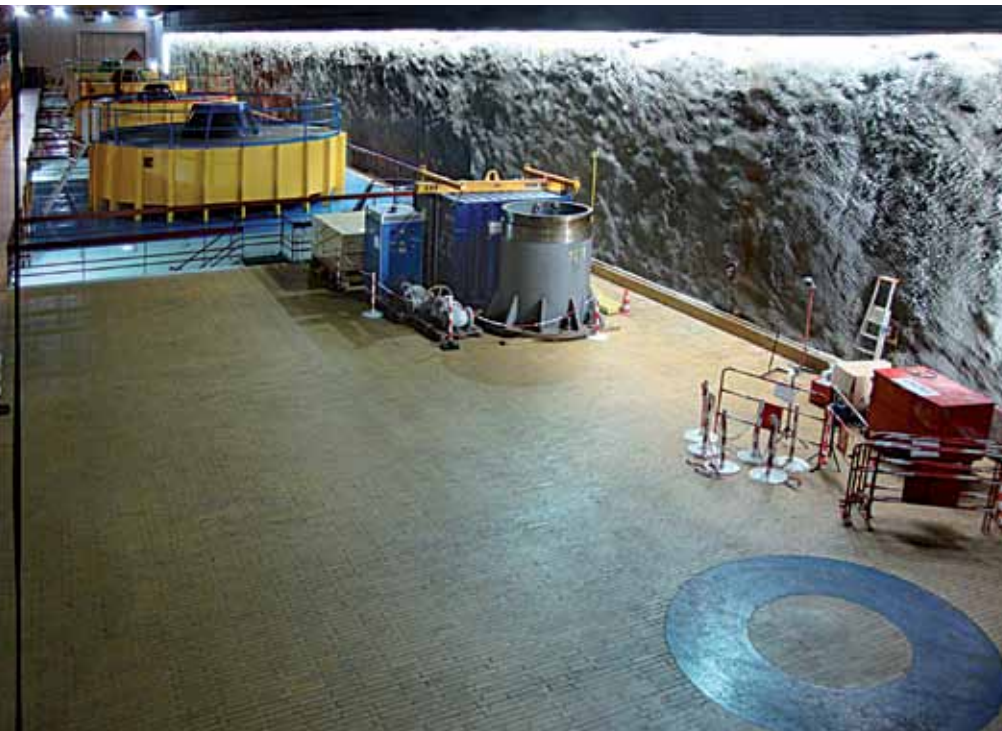
▲ Dentro do tunel
