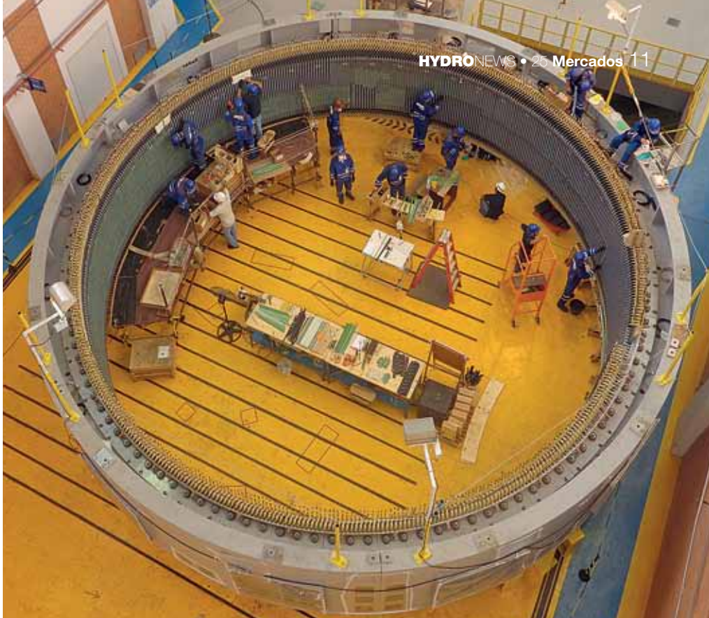
▲ Montagem de enrolamentos na UHE de Cachoeira Dourada
