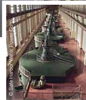
▲ Casa de força
