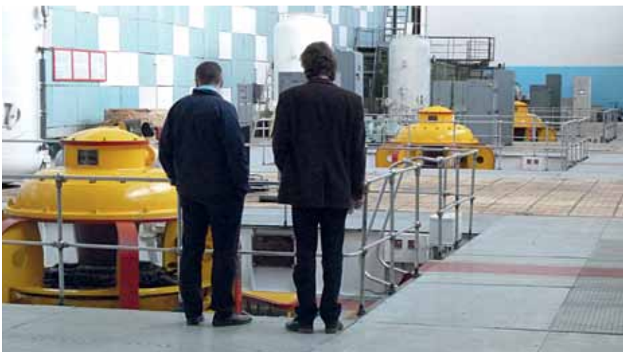
▼ Casa de força
