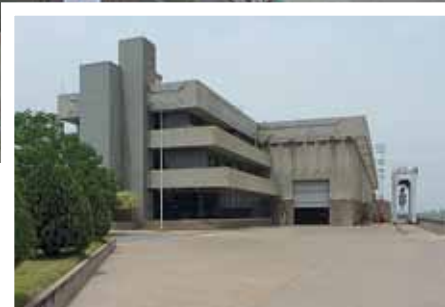
▲ Sala de máquinas com quatro unidades geradoras
