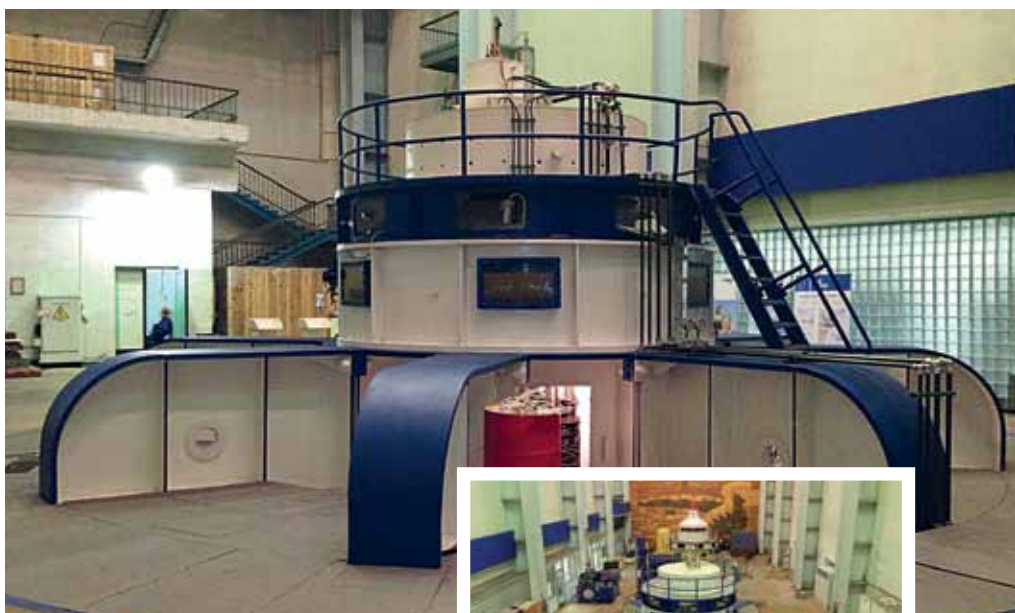
▲ Unidade 1 fornecida pela ANDRITZ HYDRO
