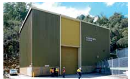
▲ Usina Hidrelétrica de Fisher
