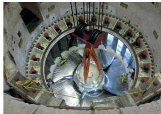
▲ Içamento da turbina
