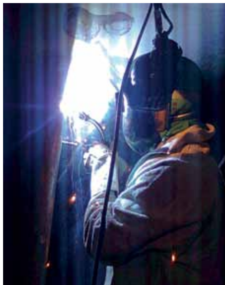
▲ Serviço de reparo de cavitação na UHE de Taquaruçu
