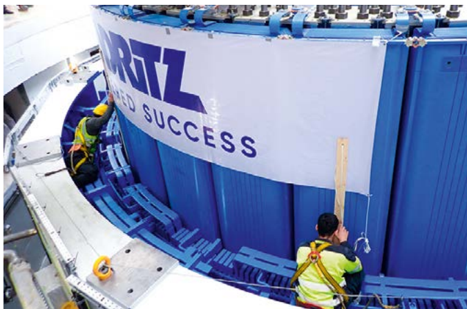
Установка ротора генератора в шахту гидроагрегата А-1
