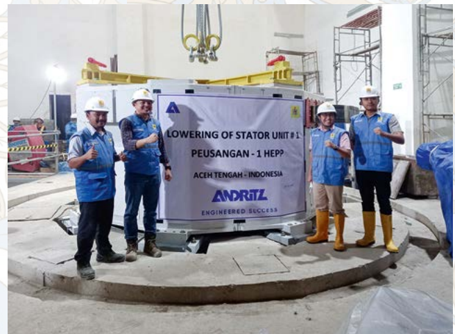
Установка статора в шахту на ГЭС «Пеусанган 1»
