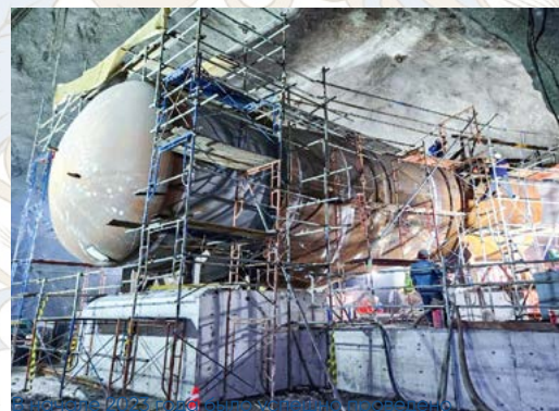
Испытание под давлением бифуркатора ГЭС «Асахан 3».
