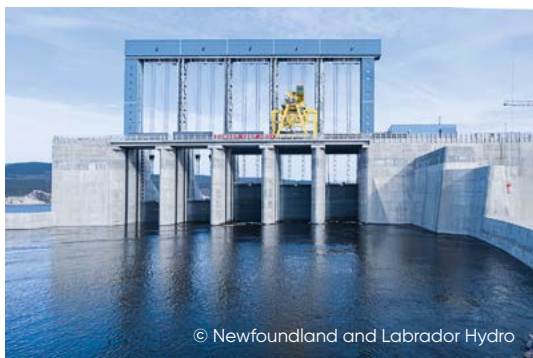
Затворы водозабора с сорозащитными решетками
