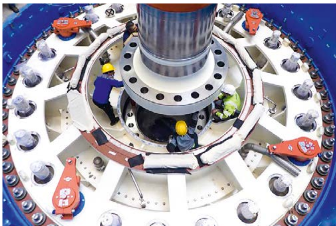
Установка вала турбины и направляющего аппарата на гидроагрегате А-1
